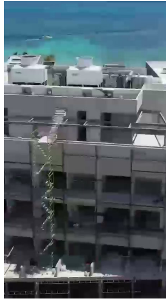
Real drone footage · construction progress · v50.jpg
