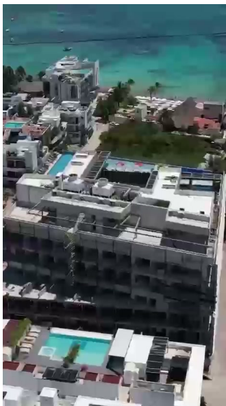
Real drone footage · construction progress · v6.jpg
